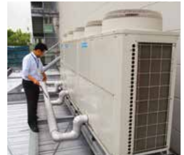
冷凍冷蔵設備の定期点検
