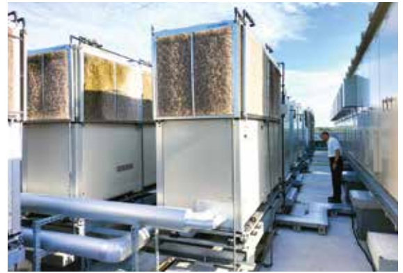
草加要冷セットセンターに設置したノンフロン冷凍機
