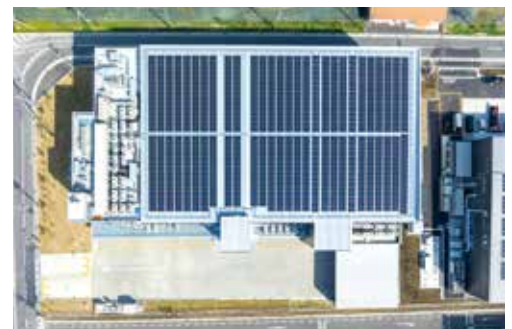
上空から見た草加要冷セットセンターの太陽光発電パネル
