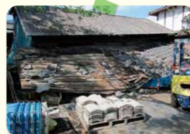
機械倉庫は全壊によりコンバインなども破損
